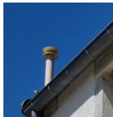
**4** La cheminée de ventilation de la fosse permet l'extraction des gaz, ainsi que des éléments volatils contenus dans les graisses. Elle est surmontée d'un extracteur dont la forme permet le tirage. Elle est placée en hauteur, loin des fenêtres et autres conduits de ventilation.
